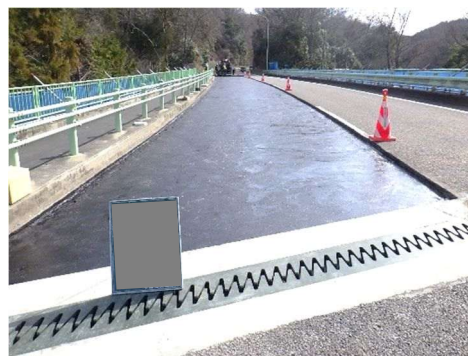
図-6 床版防水工の施工状況
