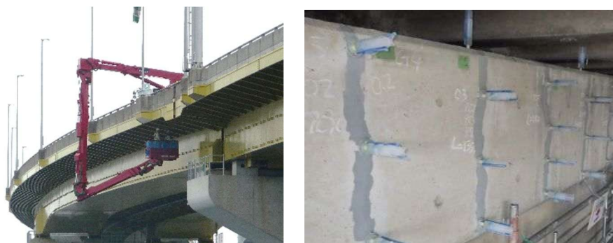
図-3 点検・修繕実施状況
