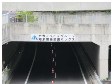
知多横断道路上り 堀割部ボックス
