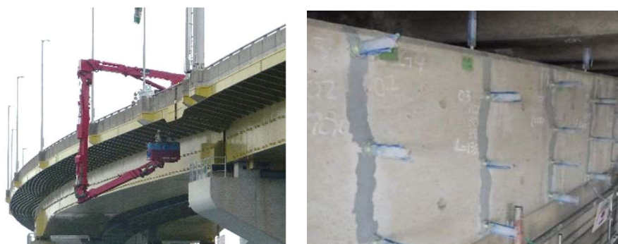
図-3 点検・修繕実施状況
