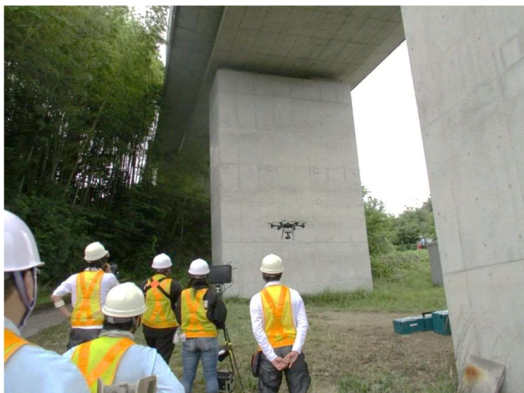
図-10 橋梁点検研修（実習）の実施状況
