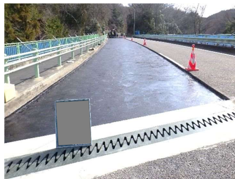
図-6 床版防水工の施工状況
