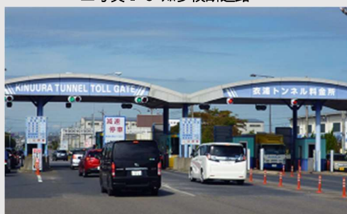
▲写真 I -5 衣浦トンネル
