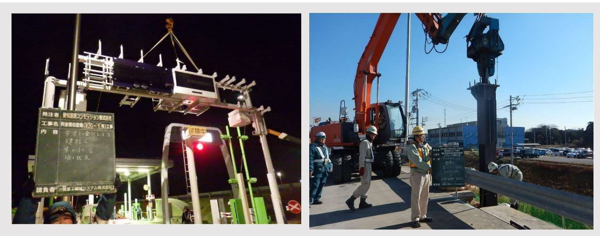
▲写真II-3-10 施工状況
