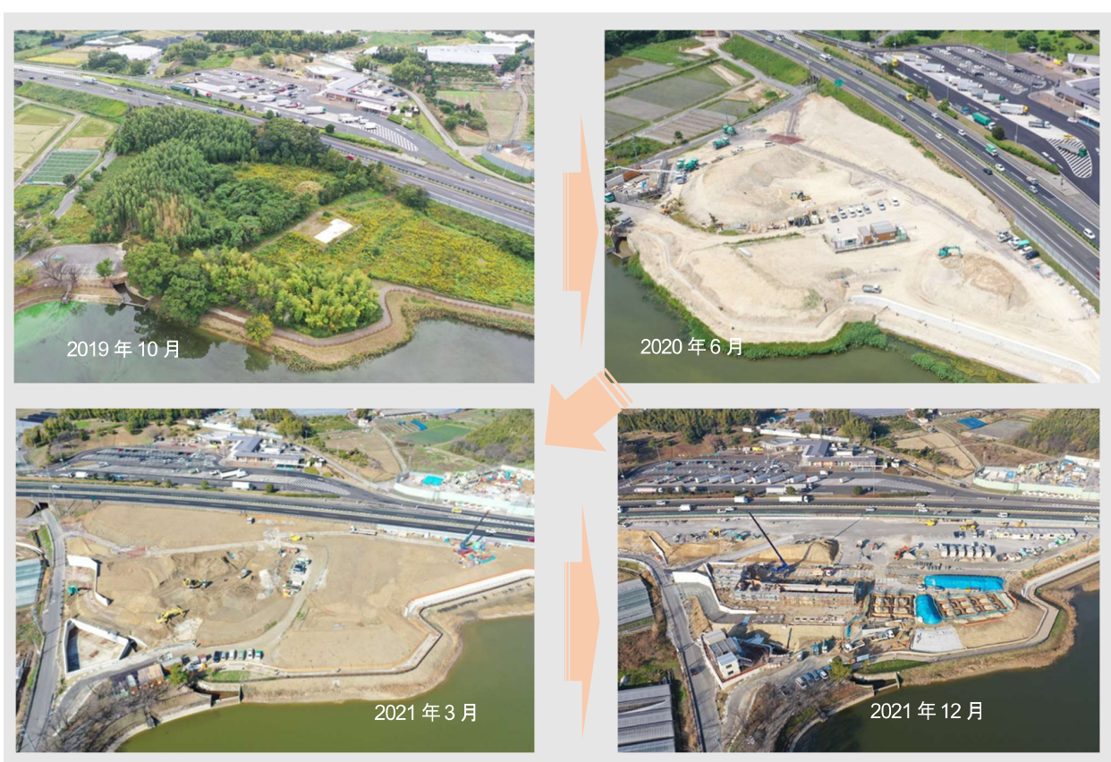
▲写真II-3-6 工事状況全景 東側上空からPAを望む
