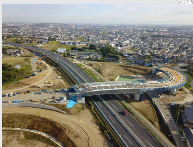
▲写真 II-3-1 工事状況全景
