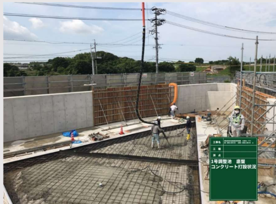
●調整池築造工事
