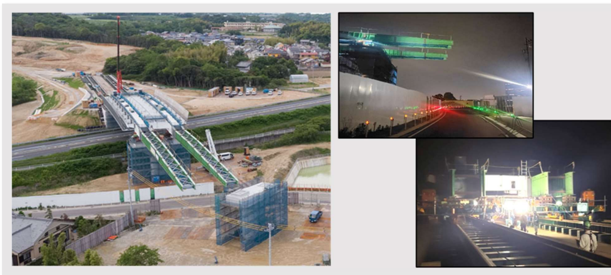
▲写真III-3-2 工事の施工状況
