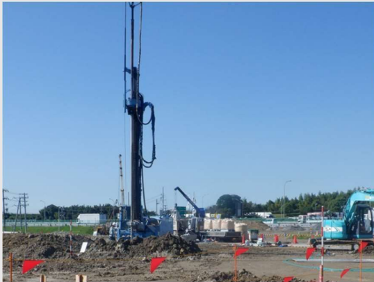
●造成・基礎工事
