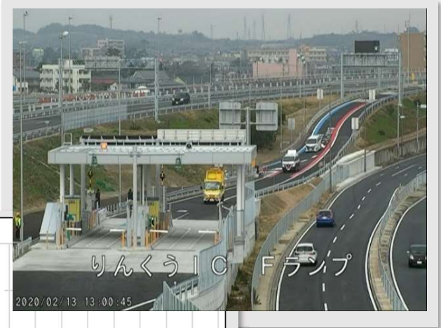
▲写真 II-3-5 新設・第 2 ランプ・料金所の供用状況 供用開始(2020年2月13日13時)
