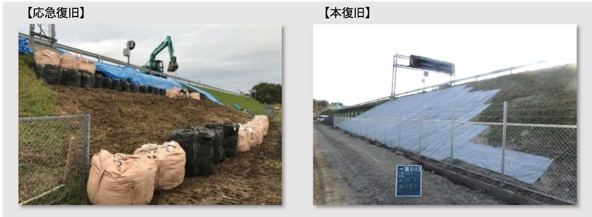
▲写真 II-2-6 災害復旧(台風被害)の実施状況
