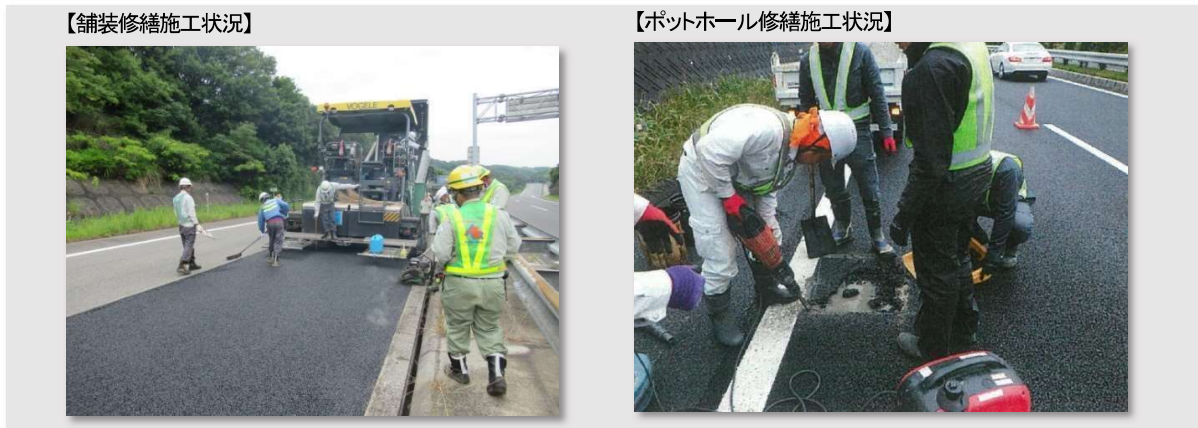
▲写真 II-2-5 舗装修繕の実施状況
