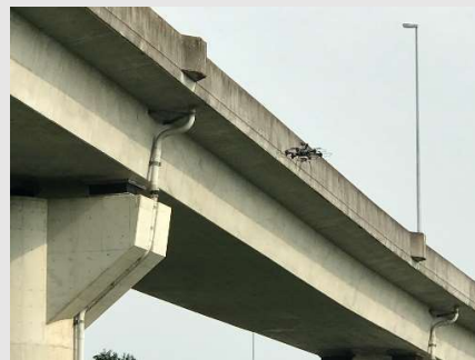
▲写真 II-2-11 高架橋におけるドローン点検
