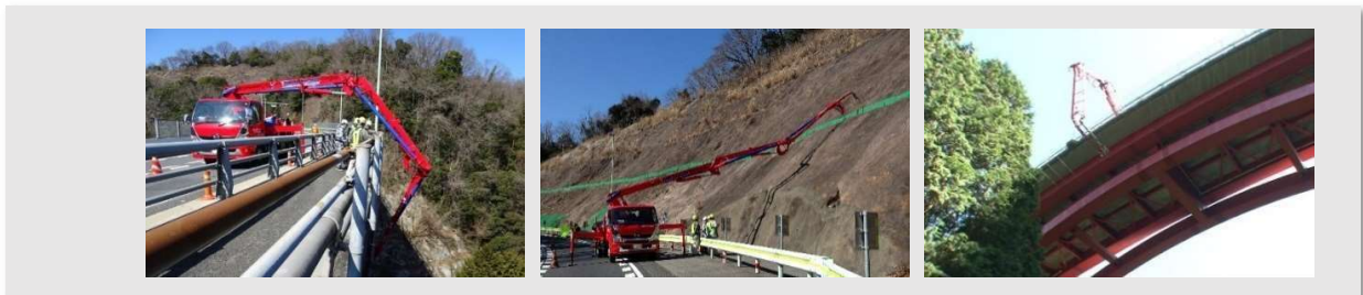
▲写真II-2-11 コンクリートポンプ車を活用した点検ロボットによる橋梁・路面点検
