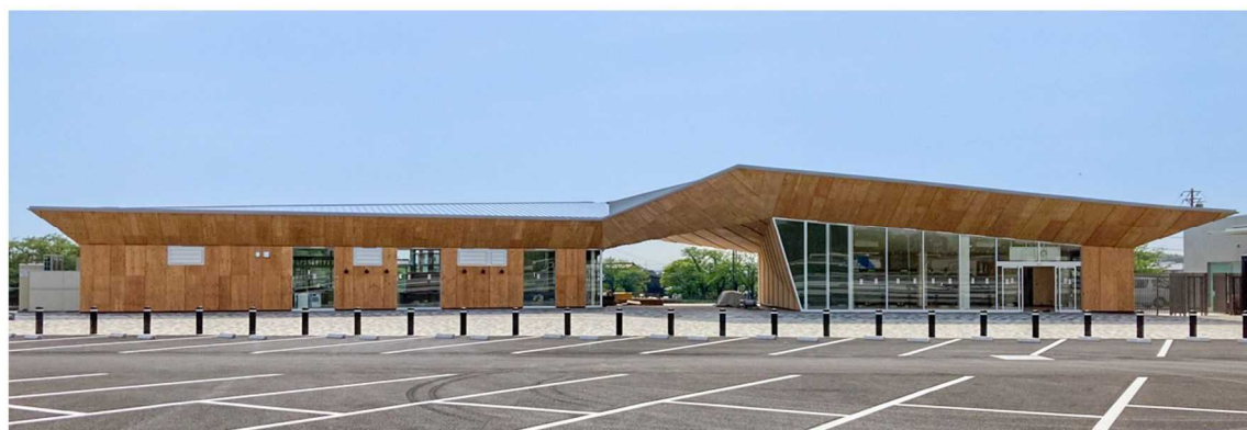
【商業施設外観】
