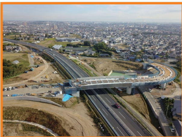
【工事中全景写真】
