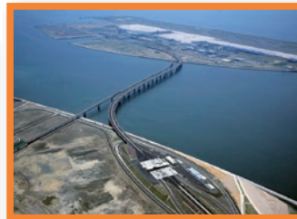
中部国際空港連絡道路
