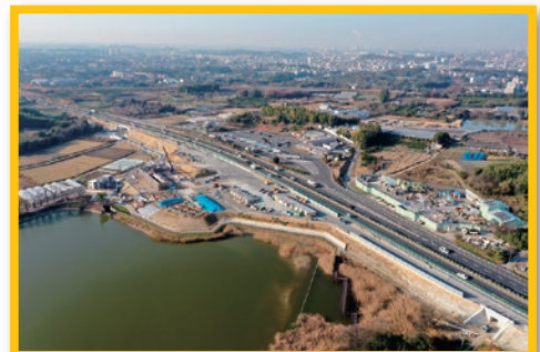
知多半島道路大府PA（下り線）整備工事 （2021年12月24日撮影）
