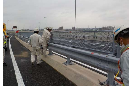
【緊急出動による復旧】
