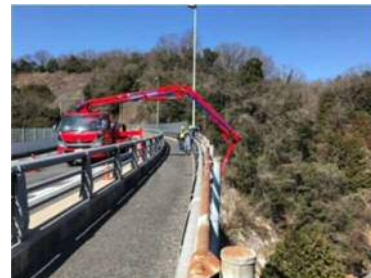
コンクリートポンプ車による橋梁点検
