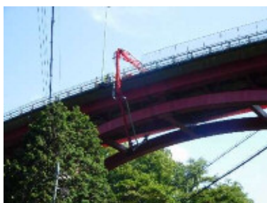
【ポンプ車による橋梁点検】
