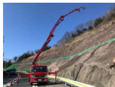
【ポンプ車による法面点検】
