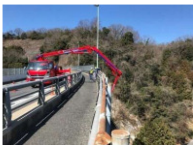
【ポンプ車による橋梁点検】
