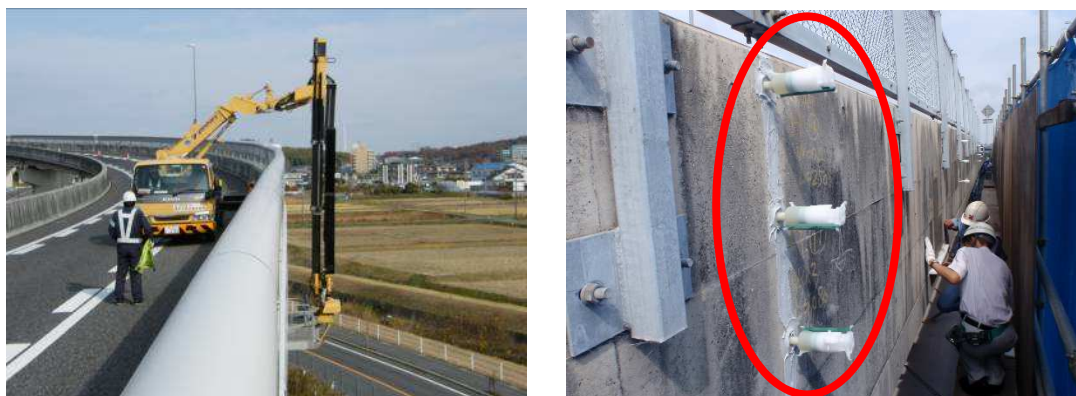
図-3 点検・修繕実施状況
