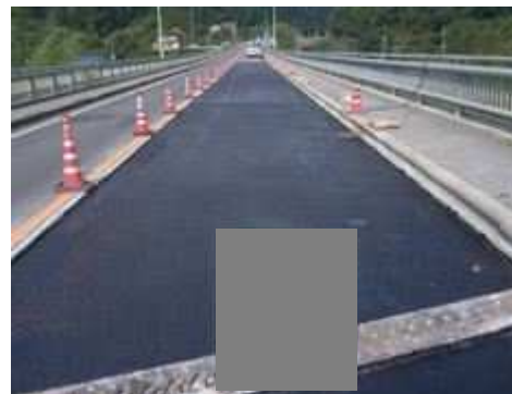
図-6 床版防水工の施工状況
