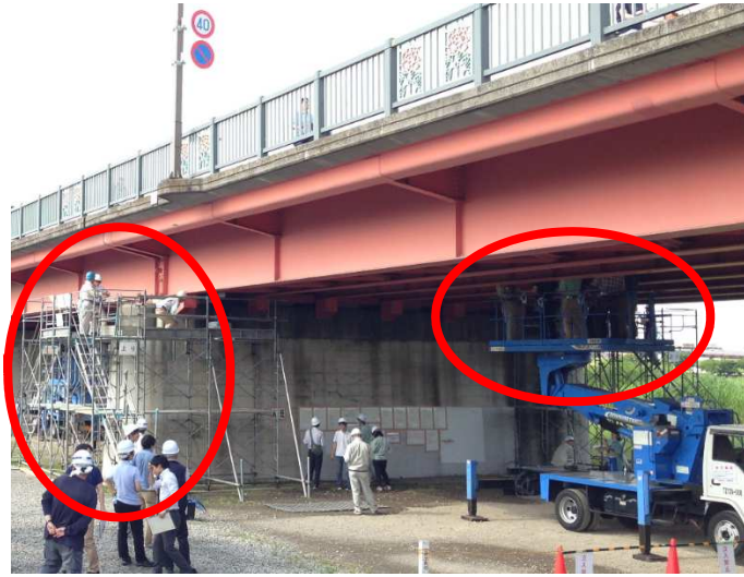
図-10 橋梁点検研修（実習）の実施状況
