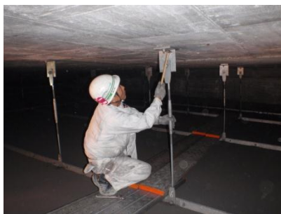
【打音調査の状況】
